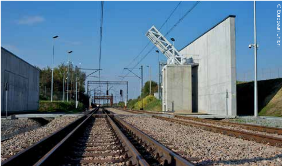
Controllo di carri ferroviari: uno scanner per treni alla frontiera tra l'Ucraina e la Polonia.
